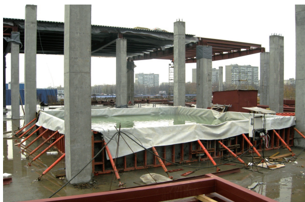
Рис. 2. Натурні випробування монолітного залізобетонного перекриття (ТРЦ «RESPUBLIKA»)
