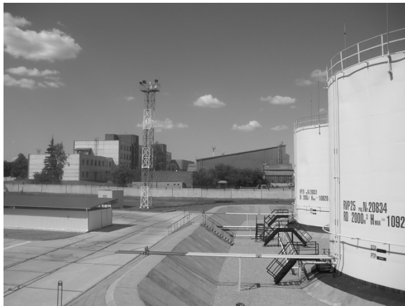
Рис. 6.15 Організація суцільного бетонного обвалування зони зберігання палив
