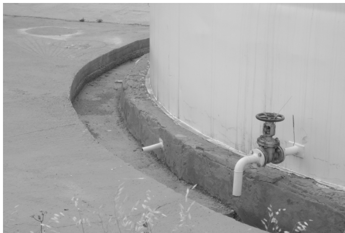
Рис. 6.13. Зовнішній вигляд резервуару з детектуванням можливих витікань палив з днища
