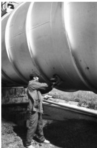
Рис. 8.4. Монтаж лінійної частини магістрального трубопроводу
