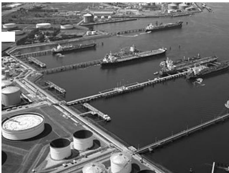
Рис. 7.5. Загальний вигляд нафтоналивного терміналу
