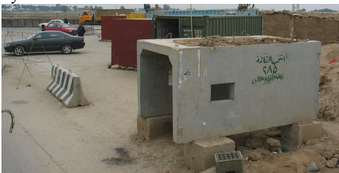
Обладнання вогневої точки (Ірак).
