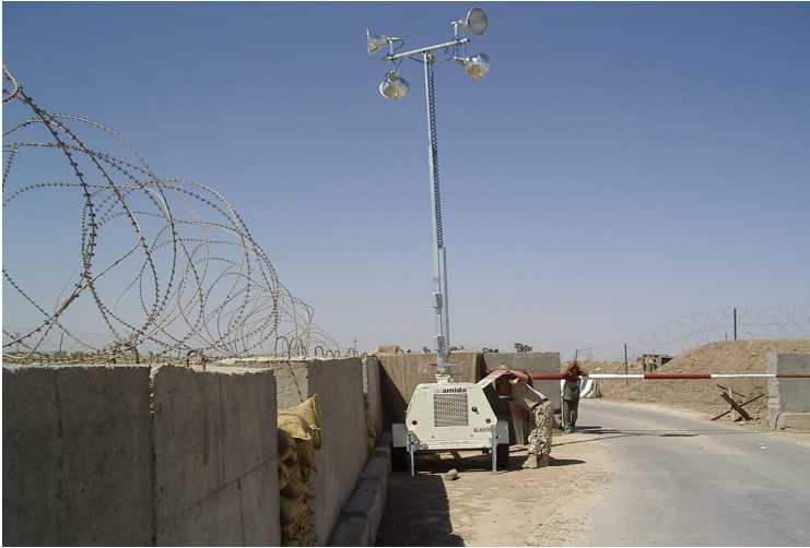
Дизельна освітлювальна станція (Ірак)
