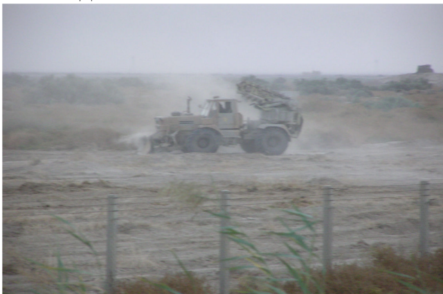
Розчистка ділянки під елемент базового табору
