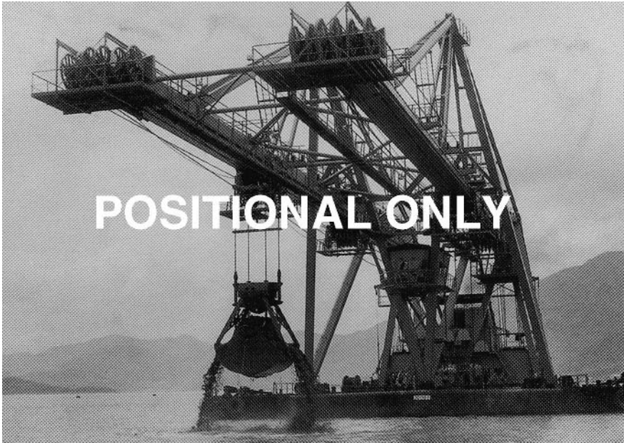
Fig. 1.4.4 Double grab unloader
